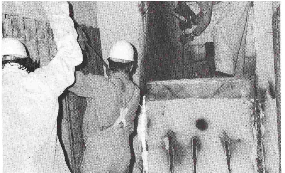
Eine zweischalige Betonwand wurde 1975 im Zentraljustizgebäude durchgeschweißt.
