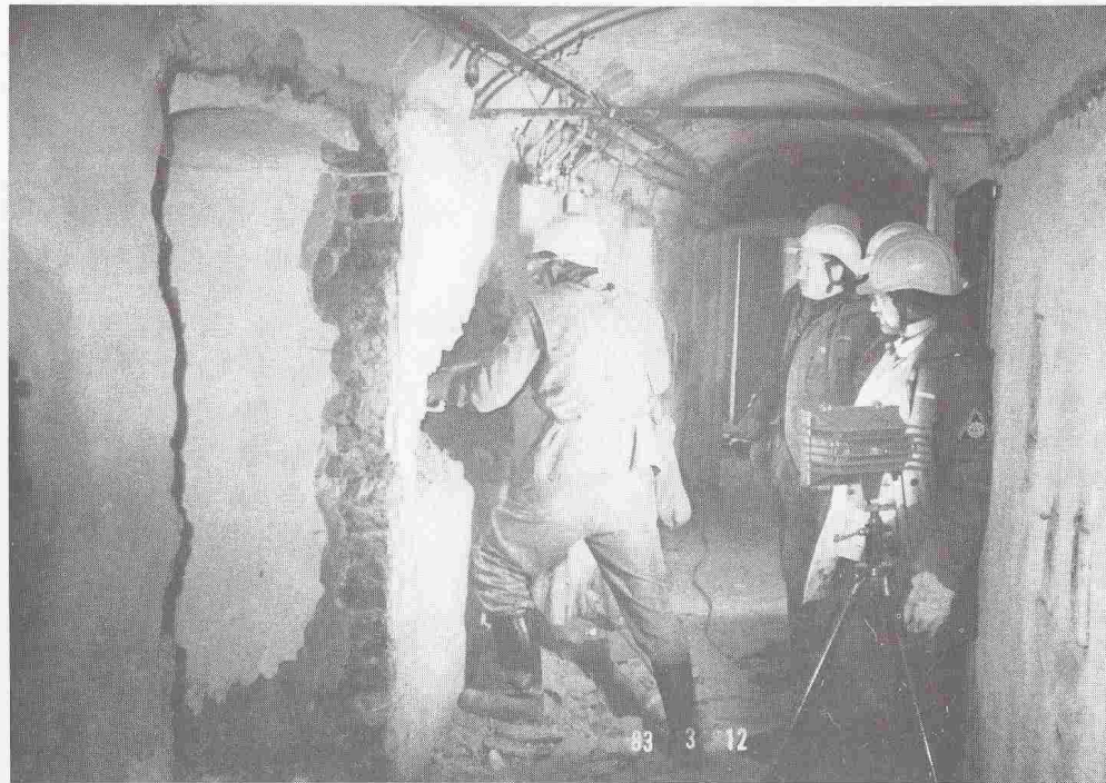
Einen hohen Stellenwert beim Ortsverband hat die Ausbildung, und hier insbesondere die Grundausbildung. Gesucht sind, wie hier dargestellt, Abbruchobjekte, in denen geübt werden kann, ohne besonderen Schaden anzurichten.
